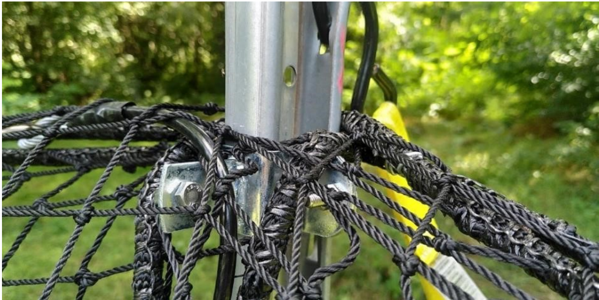
Abbildung 42: Schelle am Pfahl fälschlich mit Nase nach innen montiert (Foto: Dr. Carl Gremse)
