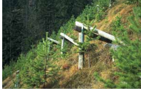
Pflanzung mit Gleitschneeverbauung, Sanierungsgebiet Elend Landkreis Miesbach
